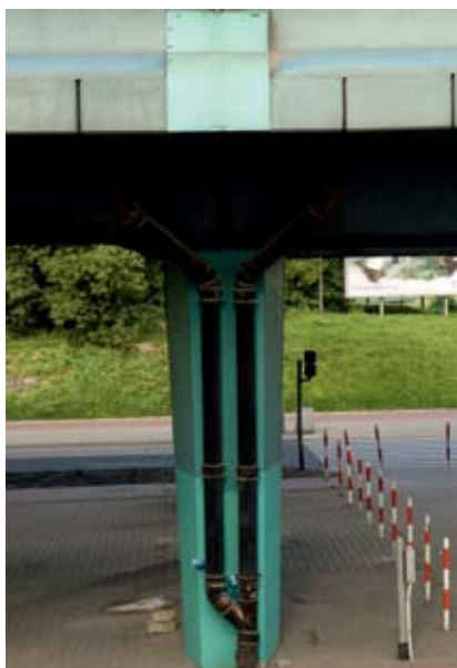
filar mostu/ Brückenpfeiler 36,5 x 24,5 cm, C-Print
