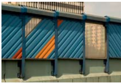
balustrada mostu/ Brückengeländer 20 x 30 cm, C-Print
